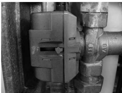
Praca z wodą wodociągową - zasysanie przez rurociąg z zaworem zwrotnym
